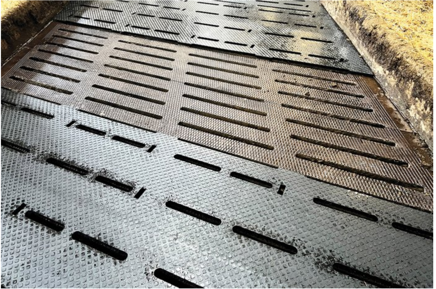
Mit espaFLEX kann die Schlitzabdeckung variabel gestaltet werden © KRAIBURG Elastik
