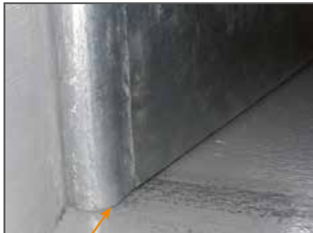
Seitliche Räumklappe Achtung: scharfe Kanten! (-> abrunden!)
