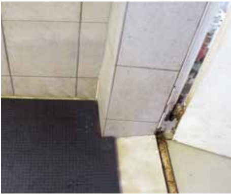
benötigte Aussparungen werden in die Matten geschnitten
