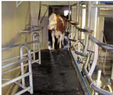
der sanierte Melkstand ist wieder einsatzbereit
