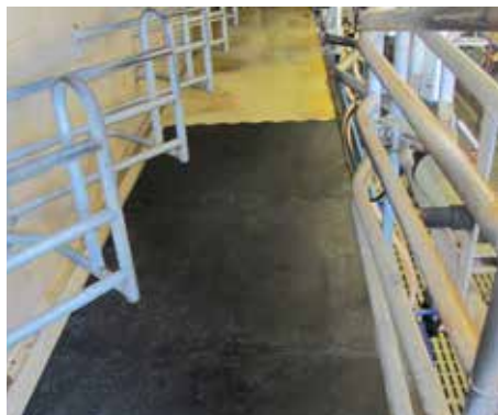
...mit den Matten ausgelegt
