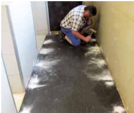
dann werden die Matten mit Nageldübeln befestigt
