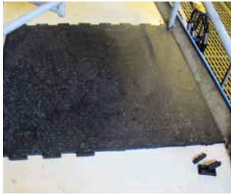
nicht benötigte Puzzleteilchen am Ende einer Fläche werden abgeschnitten
